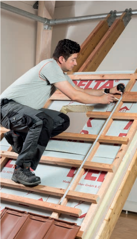
Príprava montážneho otvoru v latovaní podľa montážneho návodu.
