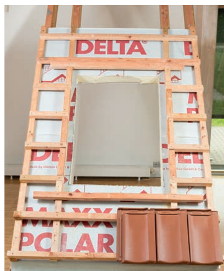
Vyrezenie tepelnej izolácie a parozábrany po vnútornej hrane označenej zateplovacej sady.
