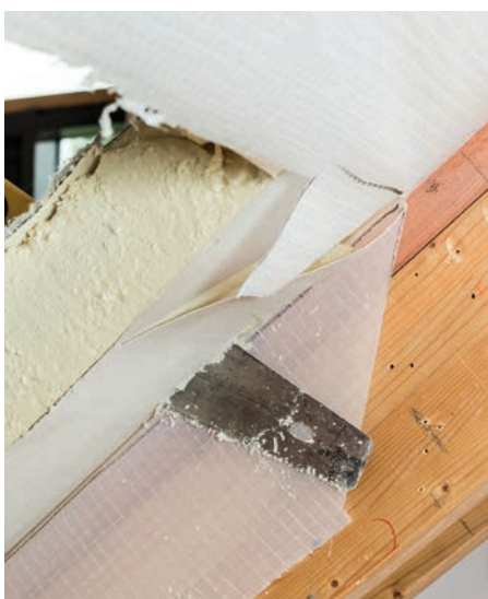
Vyrezenie tepelnej izolácie a parozábrany po vnútornej hrane označenej zateplovacej sady.
