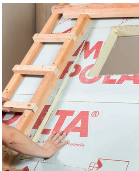
Vyrezenie tepelnej izolácie a parozábrany po vnútornej hrane označenej zateplovacej sady.
