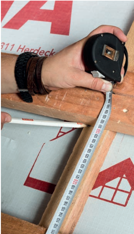
Príprava montážneho otvoru v latovaní podľa montážneho návodu.
