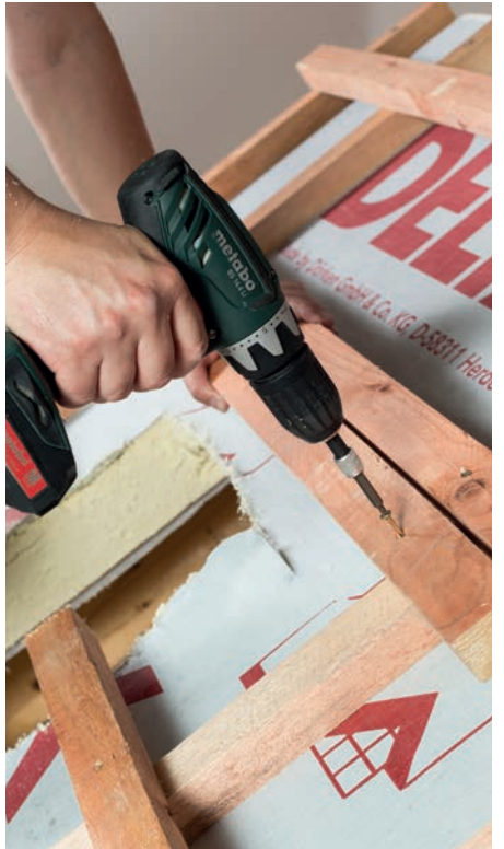
Príprava montážneho otvoru v latovaní podľa montážneho návodu.
